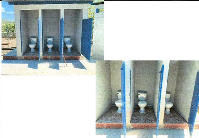
Foto1: MEJORAMIENTO DEL SISTEMA DE DRENAJES Y DE LOS SERVICIOS SANITARIOS FINALIZADO.
